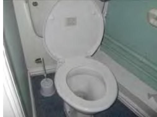
Modern non ACM toilet suite
