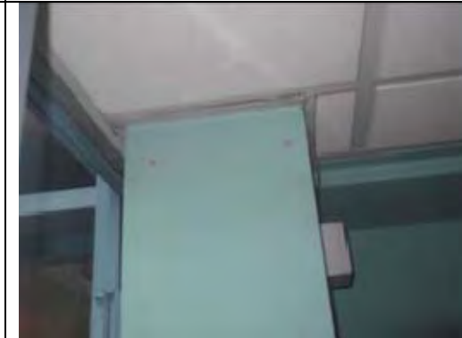
Non ACM box work
