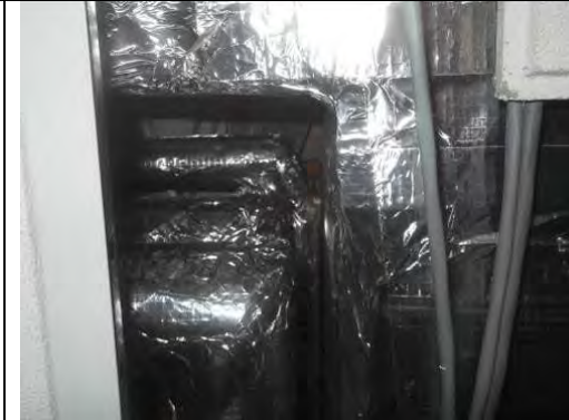
Modern non ACM lagged pipes
