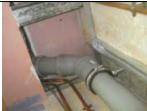
Plastic pipe. Non ACM
