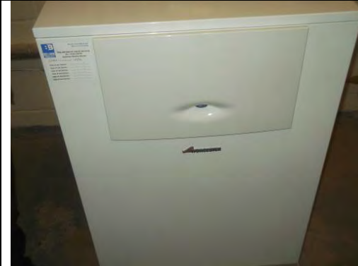
Non ACM boiler
