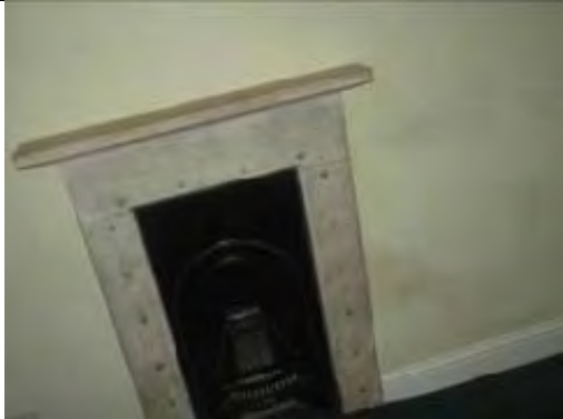
Non ACM fireplace
