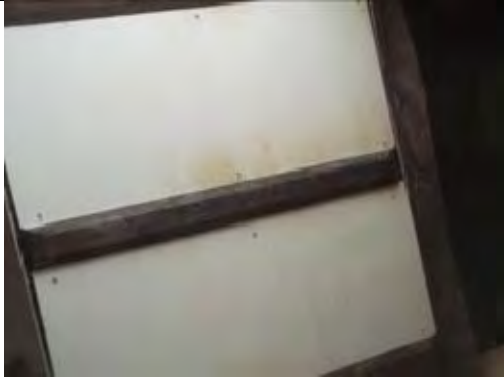
Non ACM Gyproc panelling
